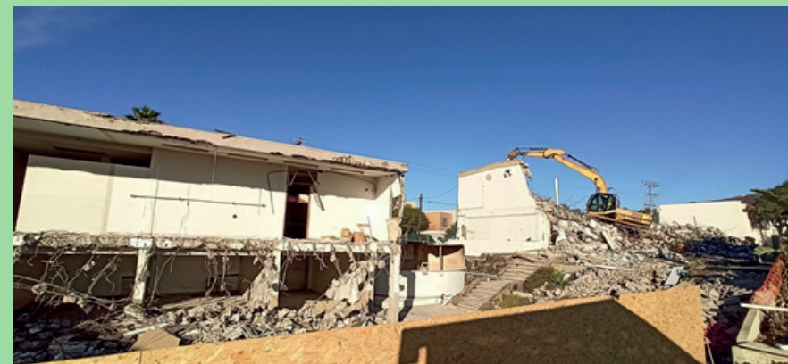
Figura 82. Demolición de edificios E15 y E16.
