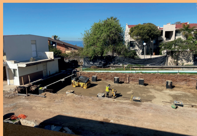
Figura 49 Cimientos del nuevo edificio E16
