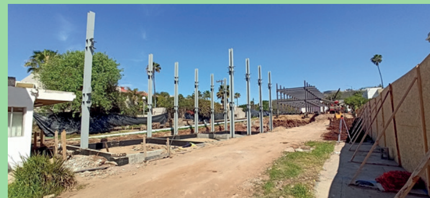
Figura 83. Construcción de edificios E15 y E16 en la FCM-UABC.
