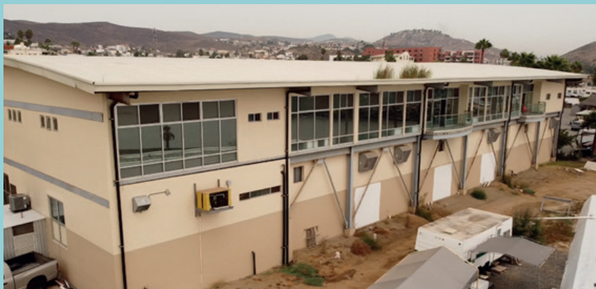
Figura 46. Imagen del exterior de la nueva Unidad de Biotecnología en Piscicultura de la FCM en UABC.
