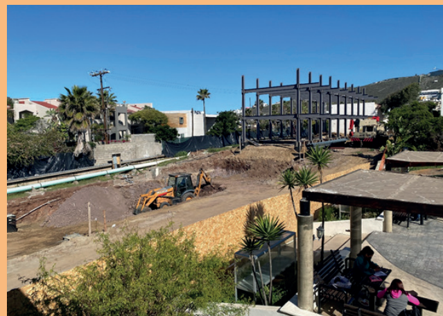
Figura 48. Al fondo el levantamiento de la estructura del nuevo edificio E15, e inicio de excavaciones del edificio E16
