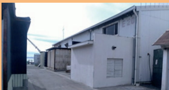
Figura 58. A la izquierda, vista exterior del edificio E20.
